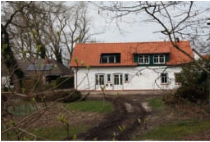
Auf der Hofstelle entstanden neue Gebäude, Wohngebäude, die Landwirtschaft wurde ausgesiedelt.
