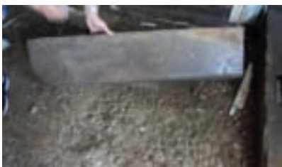
STEINPLATTE mit Gravierungen in Zweitverwendung gedreht als Trittstufe einer Innentür FLETTFUSSBODEN ausgelegt mit Weserkieseln in Mustern.
