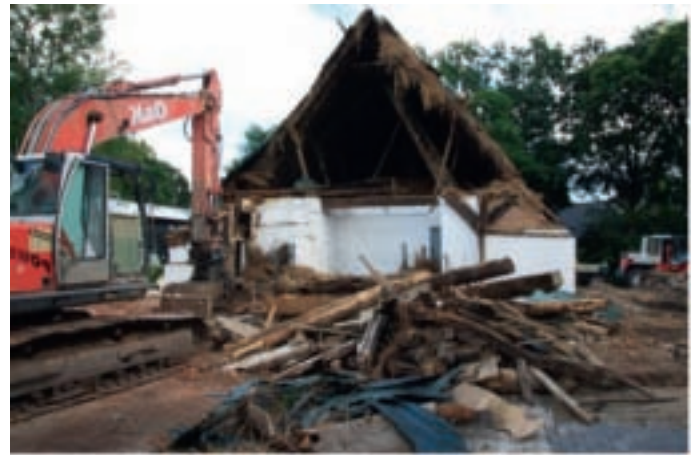
Der Bagger stand vor dem Giebel an der Wümmeseite, knabberte von oben kommend, Stück für Stück am Fachwerk, entnahm Riegel für Riegel, Ständer für Ständer, „barg“ (s.o.) den Spruchbalken über dem großen Dielentor, entfernte die Fachwerk-Giebelwand bis auf die Schwelle. Danach arbeitete er sich zur Diele vor, durch den alten Wirtschaftsteil des Gebäudes mit den Stallbereichen links und rechts unter den Kübbungen und Hillen bis zur Scheerwand, der Wand, die die Diele mit den Ställen vom Flett trennte und der Wohnbereich begann. Es folgte der Abtrag der Scheerwand und der Abriss weiter bis zur Herdwand und dem anschließendem Kammerfach. Das alte Katrepeler Bauernhaus war Geschichte.
