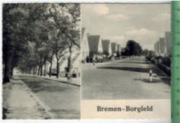
Um 1960: Borgfelder Heerstraße / Moorkuhlenweg
