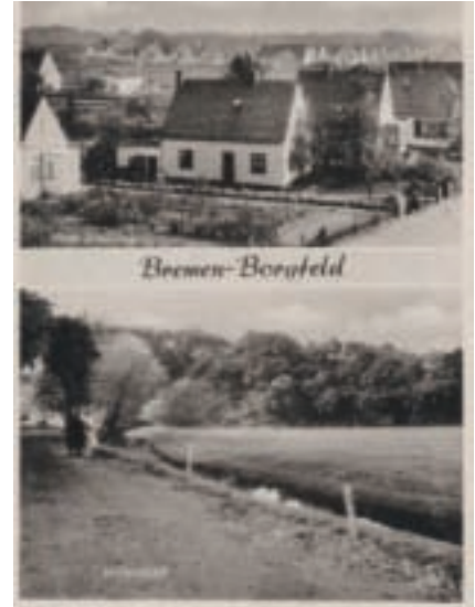
Um 1955: Bau der „Siedlung“ (s.u.) unten: Partie am Holler Deich
